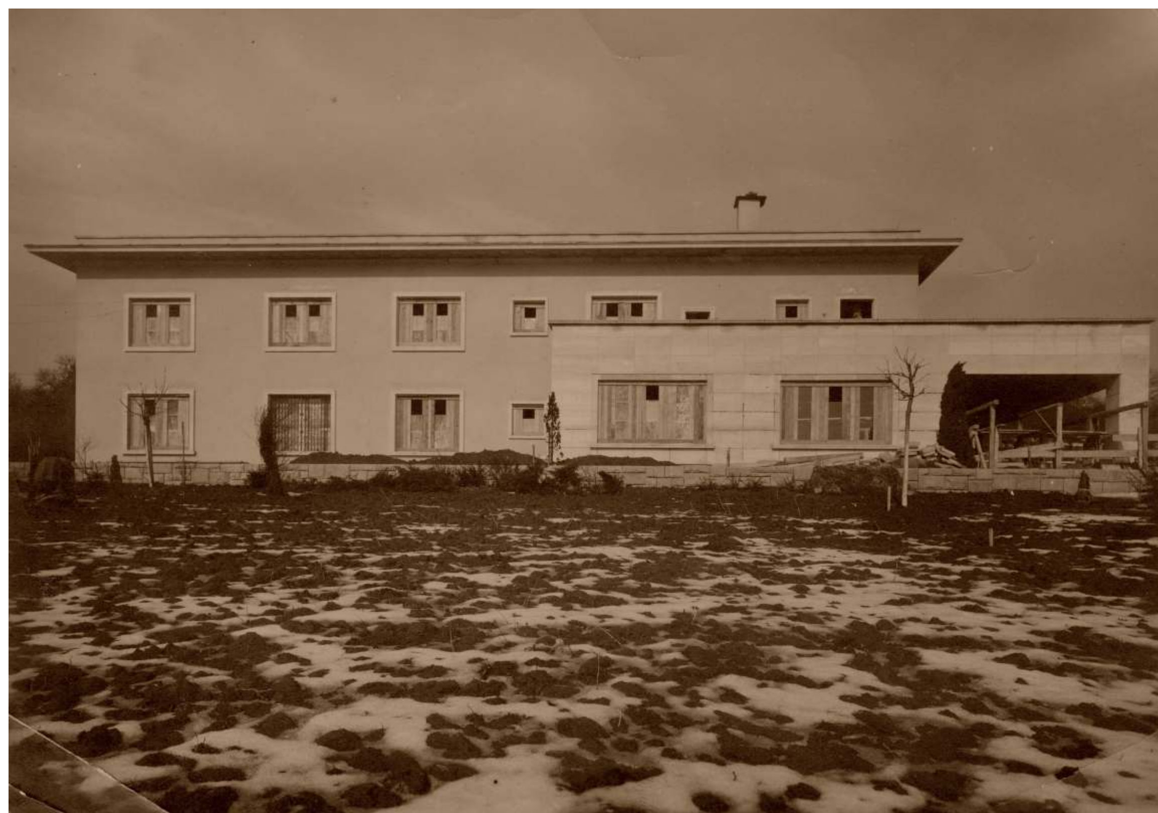
Obr. 5: Vila Stiassni (1927–1929), Brno, stav domu v průběhu výstavby, zima 1929
