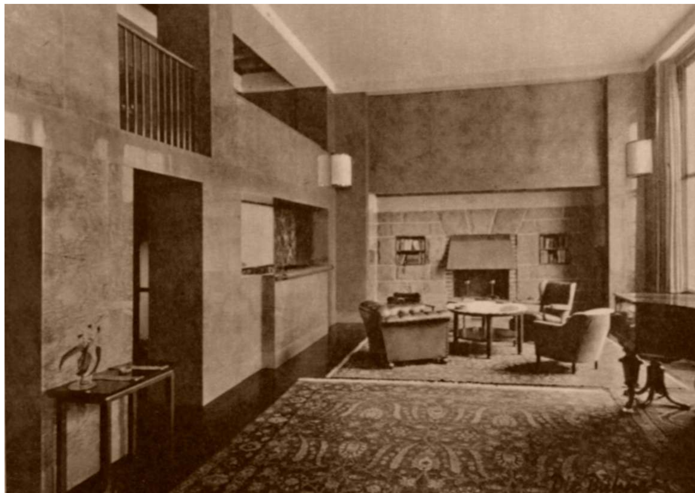
Obr. 2: Byt manželů Semlerových, Plzeň (1932–1934) , dobový snímek obývacího pokoje
