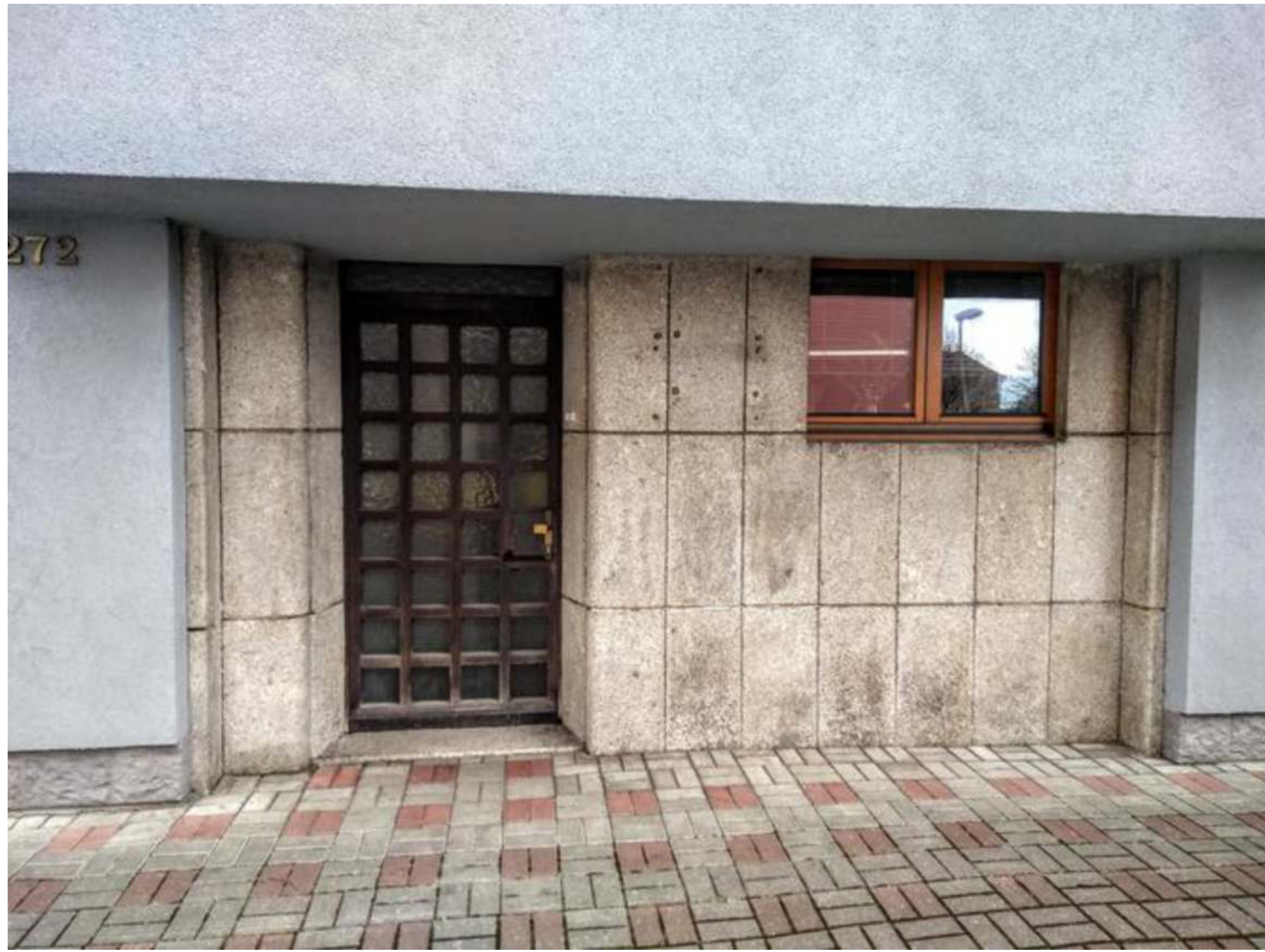
Obr. 6: Dům Dr. Ungera (1935), Sokolov, Vrchlického 272, současný stav – kamenné obložení vstupní partie
