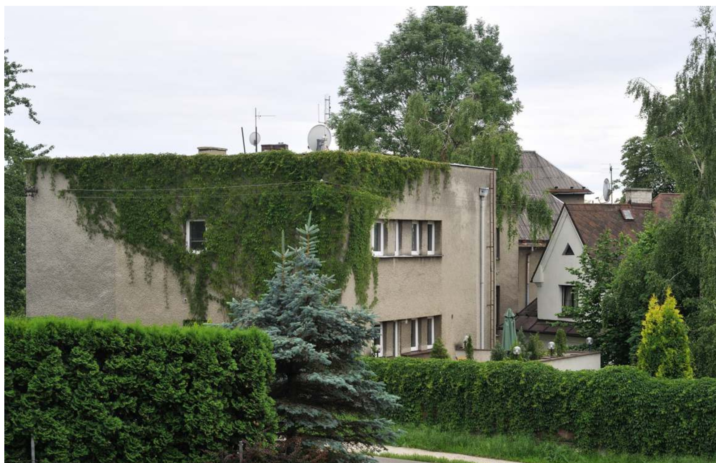
Obr. 4: Guttmannova vila, Ostrava , (1932), dnes přestavěno
