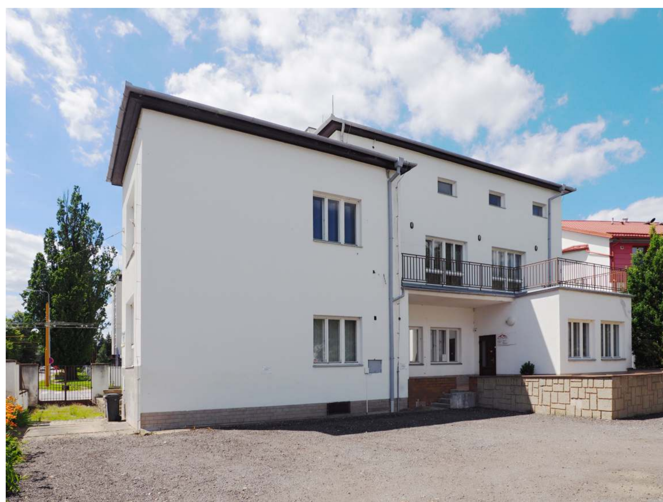
Obr. 3: vila O. Adama v Jihlavě (1929), zahradní průčelí, současný stav
